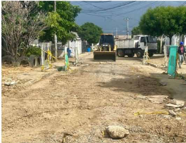
Obra finalizada por Aqualia.
