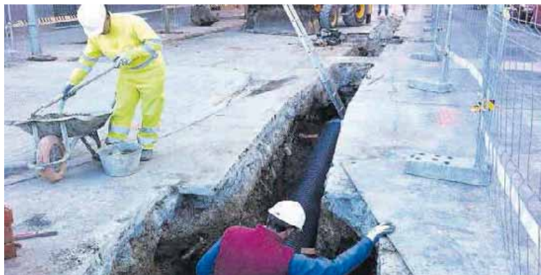
Obras en el alcantarillado de la ciudad de València.
