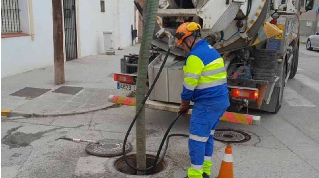
Operarios limpiando imbornales / RA
