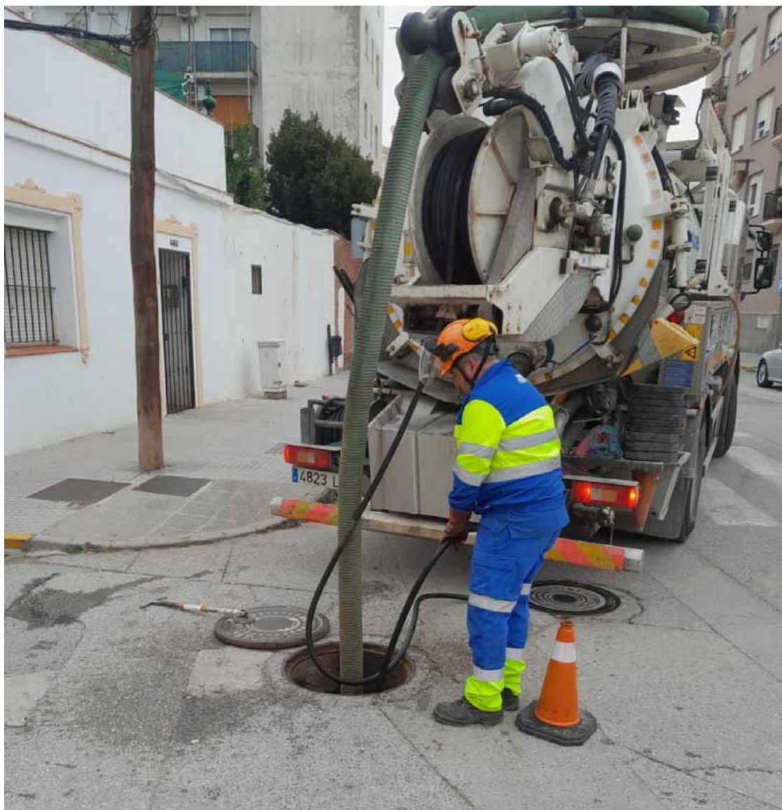
Operario de Aqualia realizando la limpieza de los imbornales - A.I.
