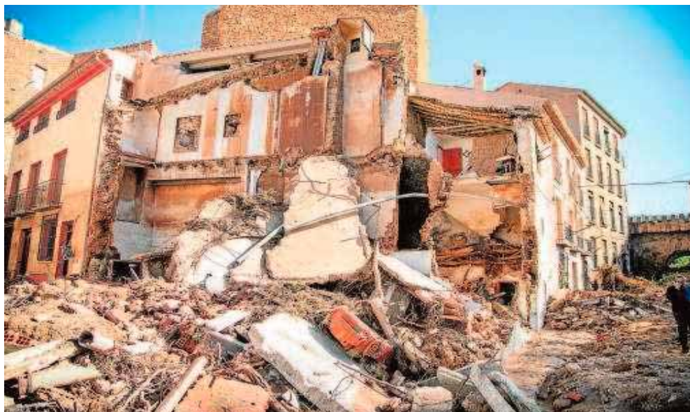
Imagen de la devastación provocada por la riada en algunos edificios del casco antiguo de Letur // JCCM
