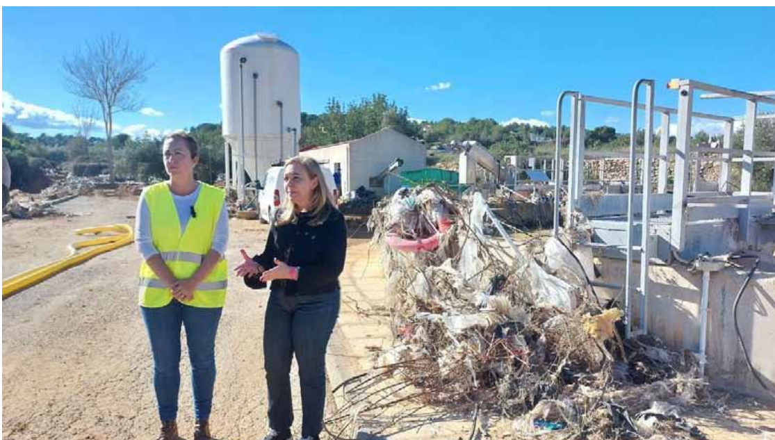
Imagen de la visita a la depuradora de Godelleta.
